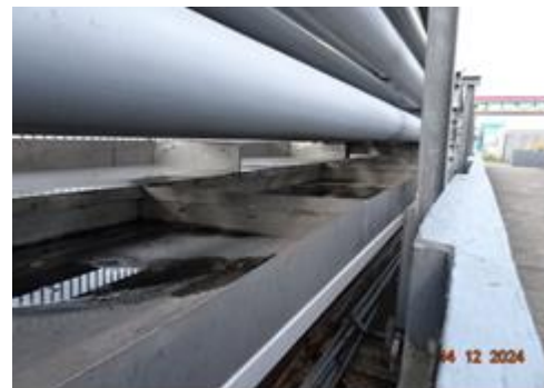
ภาพที่ 2-2 ถาดรองรับน้ำมันที่อาจรั่วไหลจากการถอดและเชื่อมต่อในการขนถ่ายน้ำมันที่ท่าเรือ
