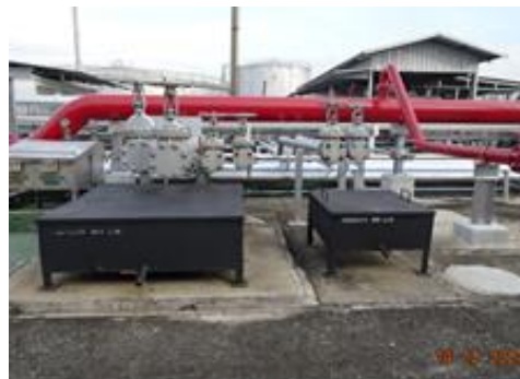
ภาพที่ 2-2 (ต่อ) ถาดรองรับน้ำมันที่อาจรั่วไหลจากการถอดและเชื่อมต่อในการขนถ่ายน้ำมันที่ท่าเรือ
