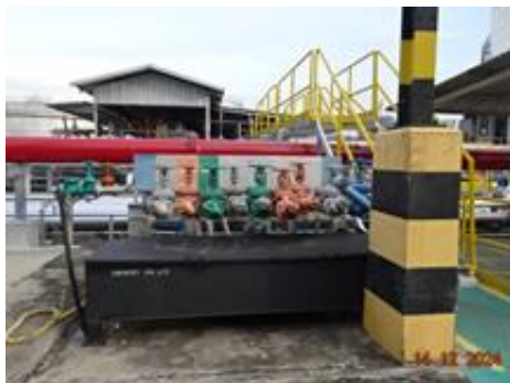
ภาพที่ 2-2 (ต่อ) ถาดรองรับน้ำมันที่อาจรั่วไหลจากการถอดและเชื่อมต่อในการขนถ่ายน้ำมันที่ท่าเรือ
