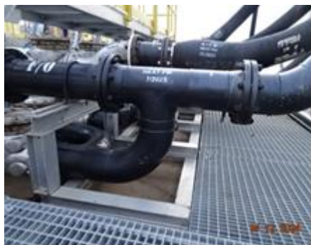
ภาพที่ 2-2 ถาดรองรับน้ำมันที่อาจรั่วไหลจากการถอดและเชื่อมต่อในการขนถ่ายน้ำมันที่ท่าเรือ
